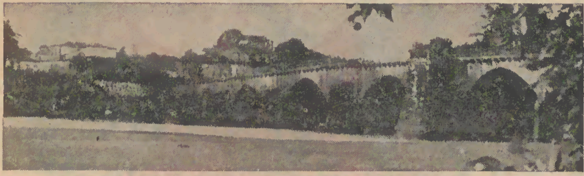
Vista parcial da ponte de Prado
