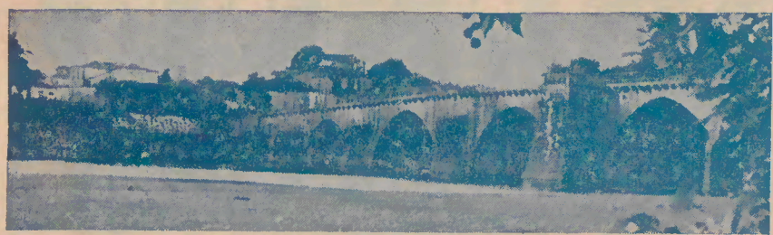
Ponte sobre o rio Cávado
