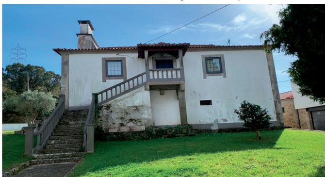
anos o telhado precisa de ser restaurado, com a mudança do madeiramento, incluindo remoção de telha e tetos e a colocação de telhas cerâmicas novas, de cor vermelho, do tipo Coelho da Silva Tecno — como a Igreja Paroquial —, cumes, tamancos e cruzetas, assim como execução de vedações em chapa de zinco, compreendendo cortes, fixações, dobragens e todos os trabalhos necessários à sua correta execução.
