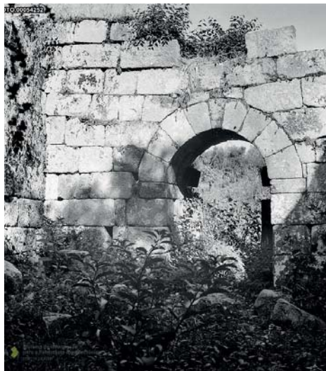
PORTA INTERIOR DO SOLAR DE VASCONCELOS
