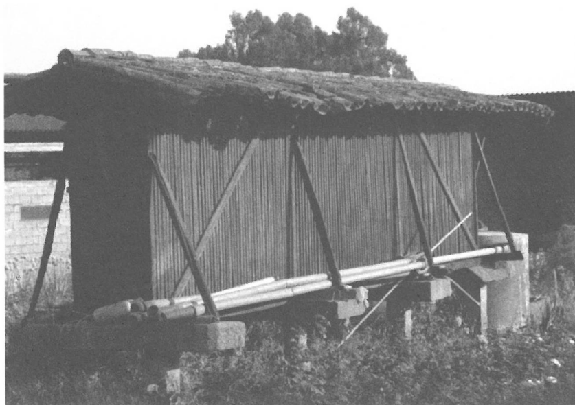
ESPIQUEIRO AVELHADO EXISTENTE NA QUINTA DE ARCA
