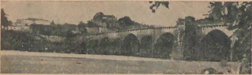
Ponte sobre o Rio Cávado
