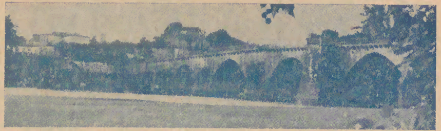
A Ponte sobre o Rio Cávado
