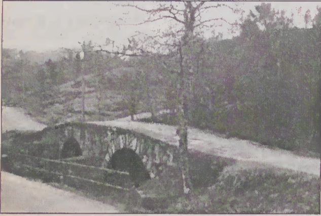
A ponte enganosa...
