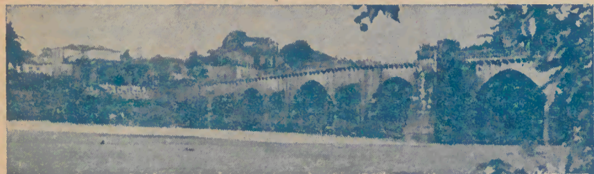
Ponte sobre o Rio Cávado
