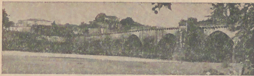
Ponte sobre o Rio Cávado
