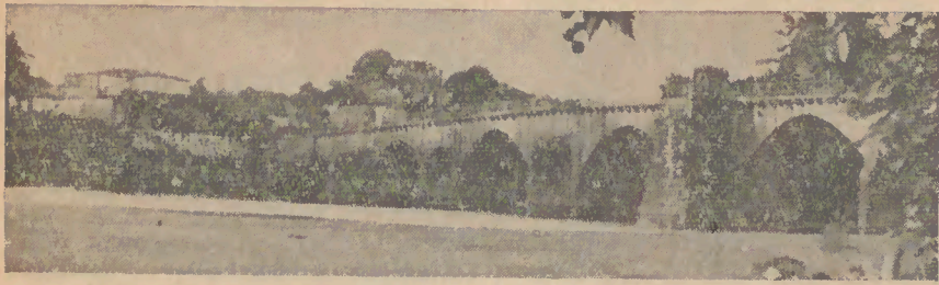
Ponte sobre o Rio Cávado
