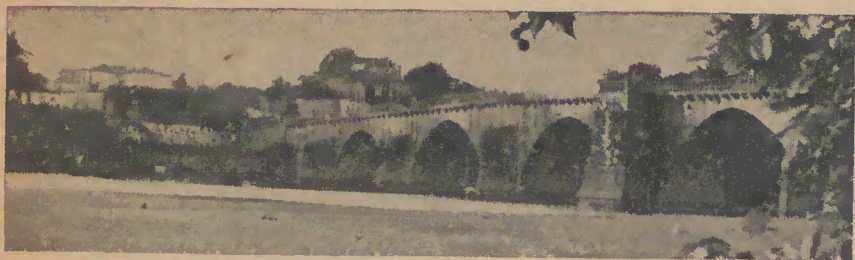
Ponte sobre o Rio Cávado
