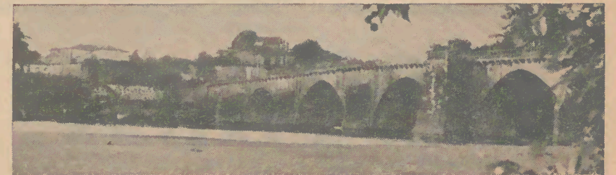
Ponte sobre o Rio Cávado
