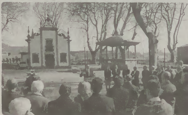
O Município de Esposende vai proceder à remodelação do adro da capela da Senhora da Saúde, em Esposende, o
