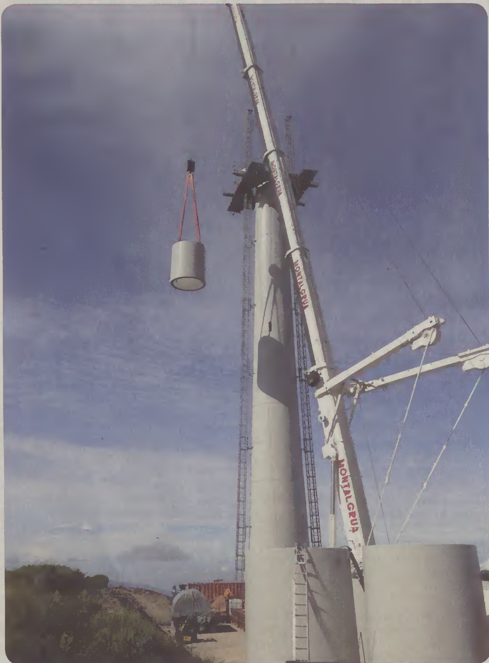
Montagem do Sobreequipamento do Parque Eólico de S. Pedro
