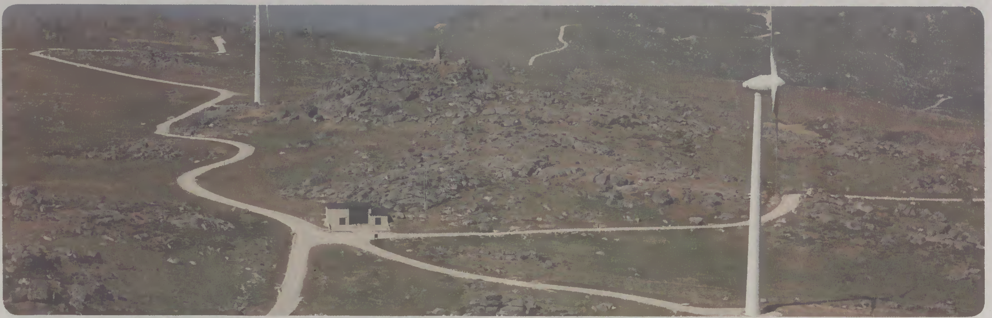
»»» Aerogeradores do Parque Eólico de Pinheiro
