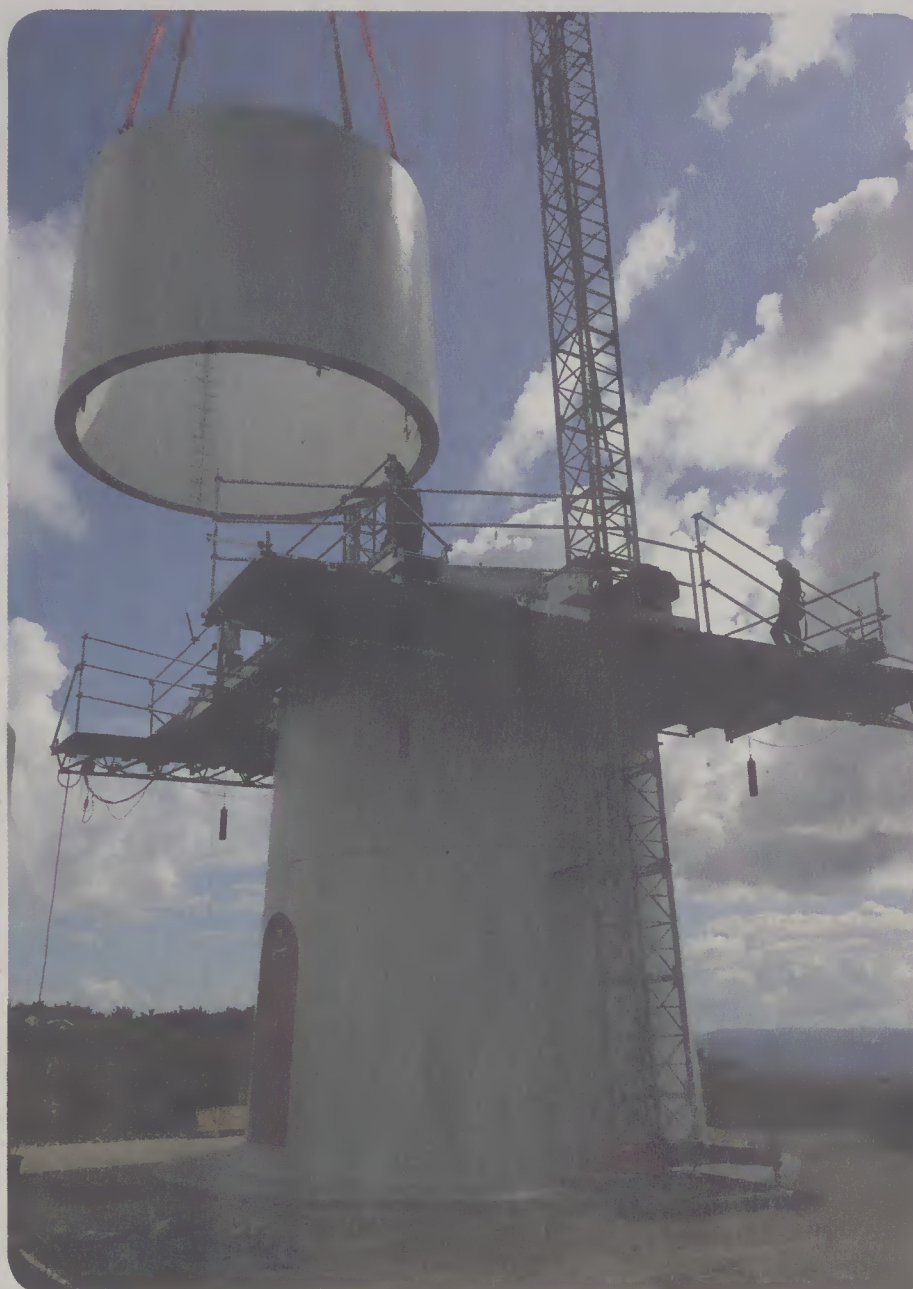
Montagem do Sobreequipamento do Parque Eólico de S. Pedro
