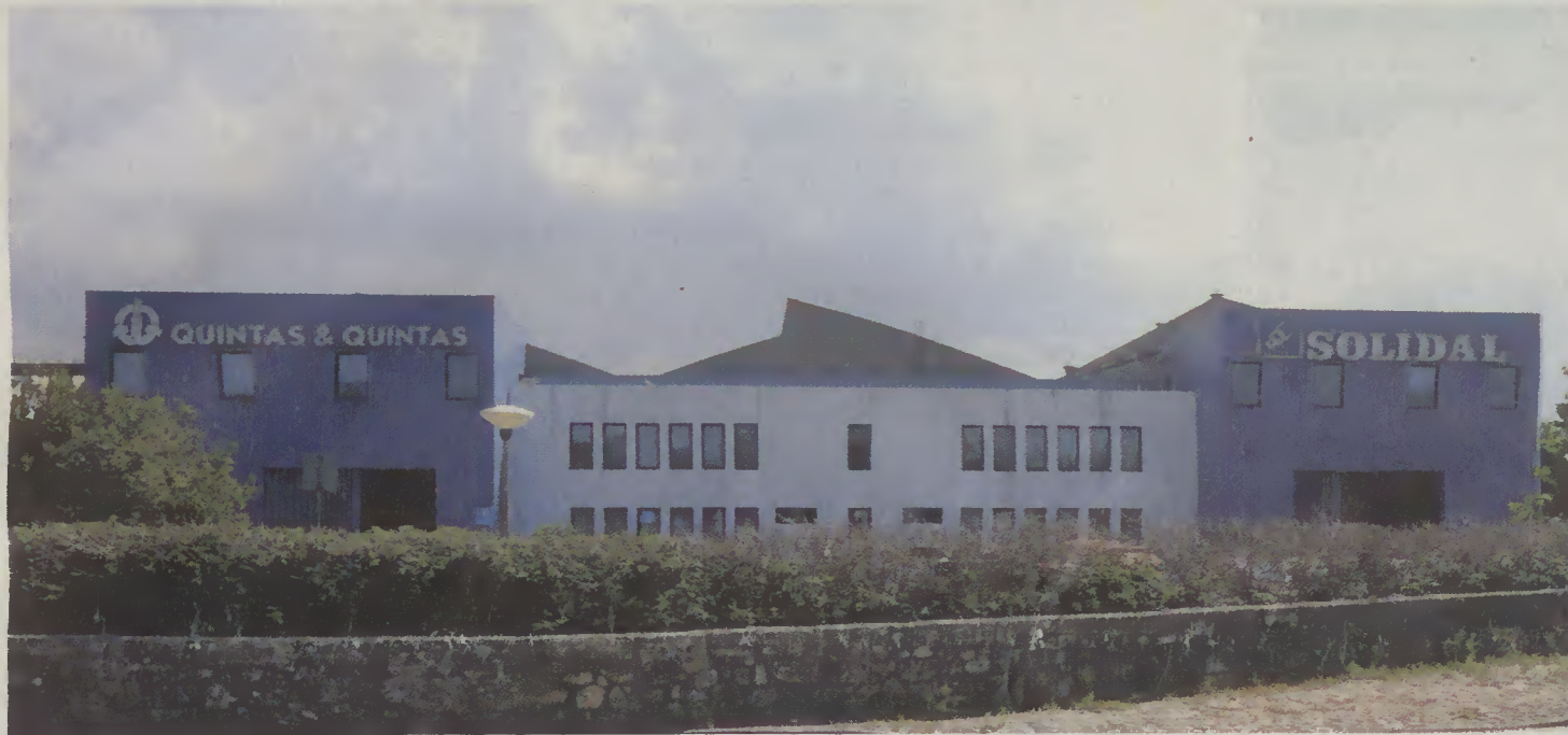
Fachada principal do complexo fabril da SOLIDAL. PÁG. 05
