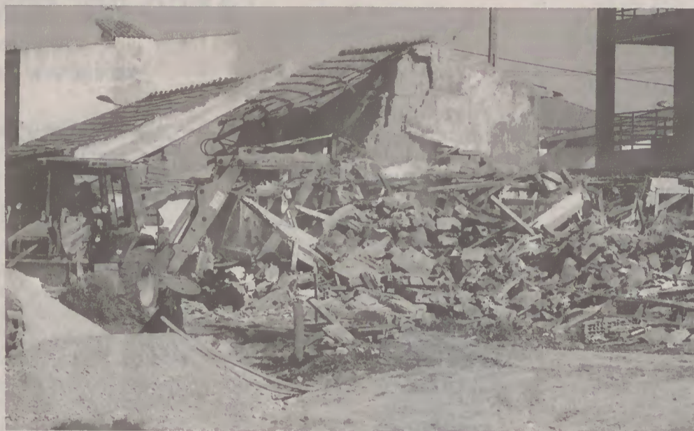
As demolições decorreram na semana passada
