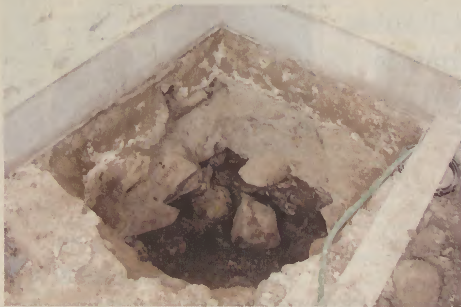
Já foram iniciados os trabalhos de fundações
