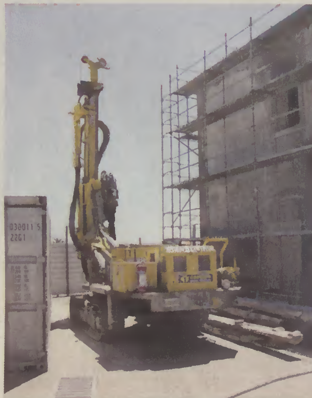
A colocação de micro-estacas, para reforço da estrutura, é o próximo passo
