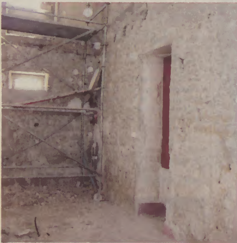
Depois da demolição interior, as picagens das paredes vão em bom ritmo
