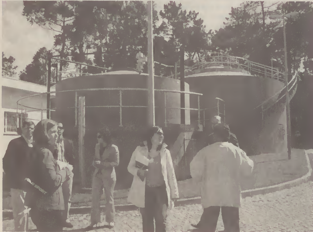
Estação de Tratamento de Lamas
