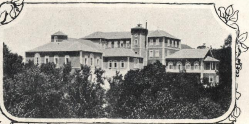
Parque da Estancia das aguas de Entre-os-Rios
