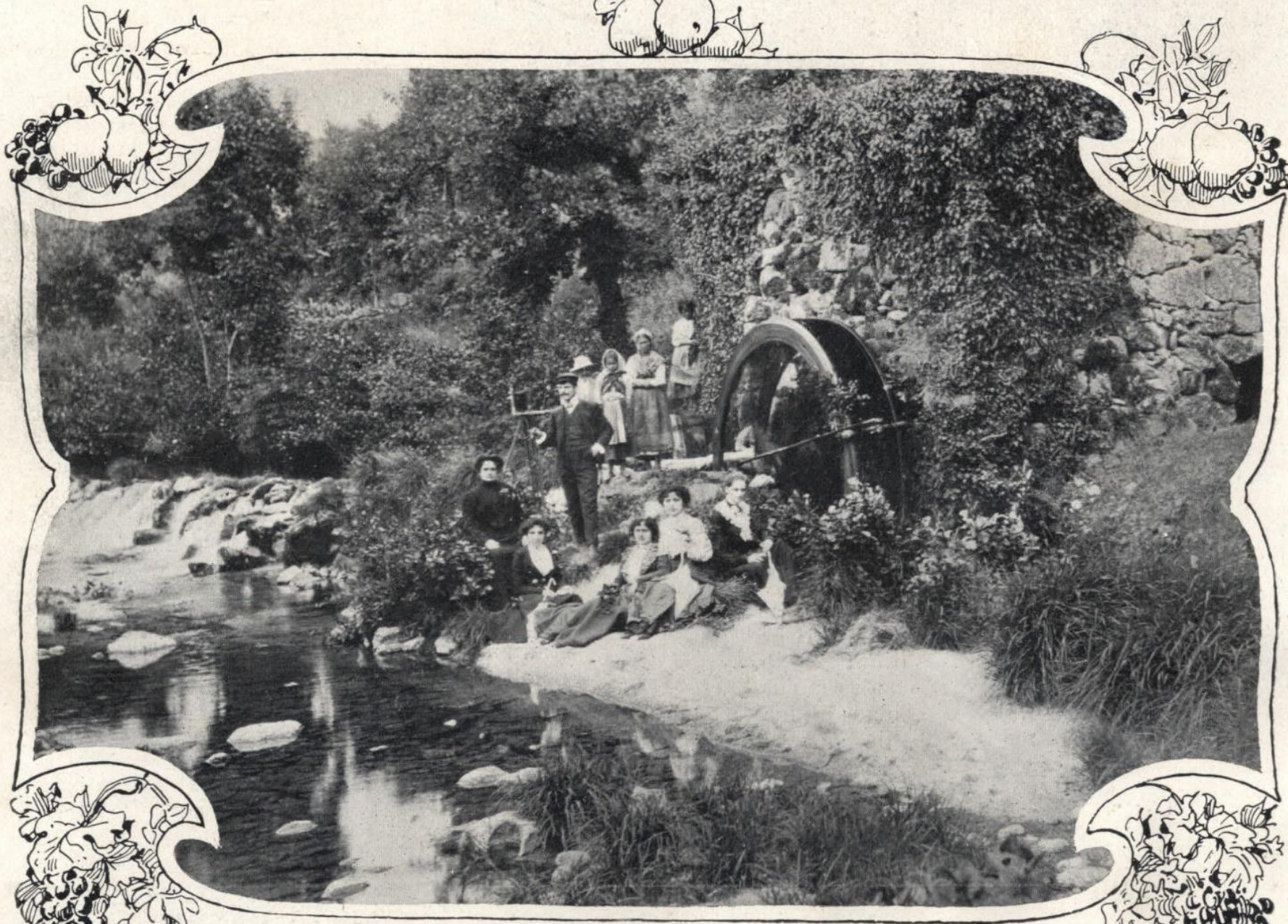
Caldellas: Queda de agua no logar de Vau
