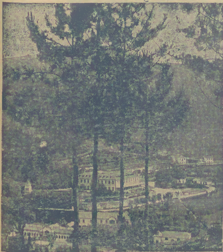
Trecho parcial de Caldelas e Grande Hotel da Bela Vista
