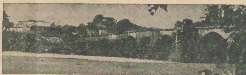
Vista parcial da ponte sobre o Rio Cávado
