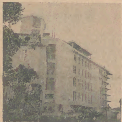
Edifício novo da Faculdade Pontifícia de Filosofia
