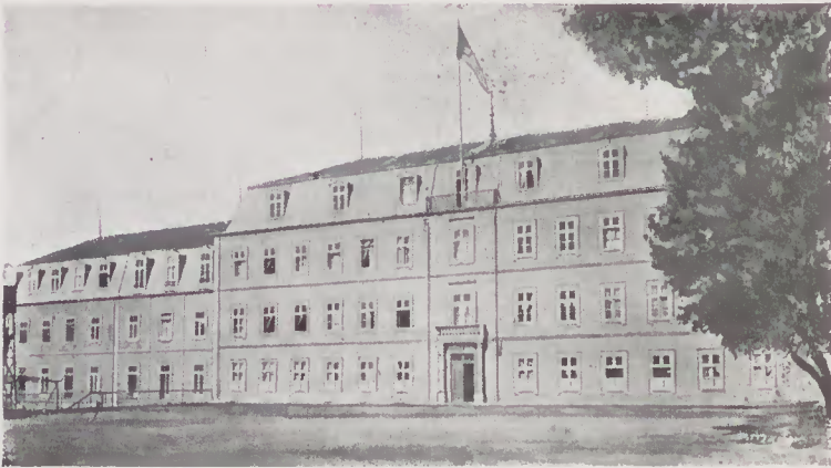
EDIFICIO PRINCIPAL DO COLLEGIO ( lado sul )
