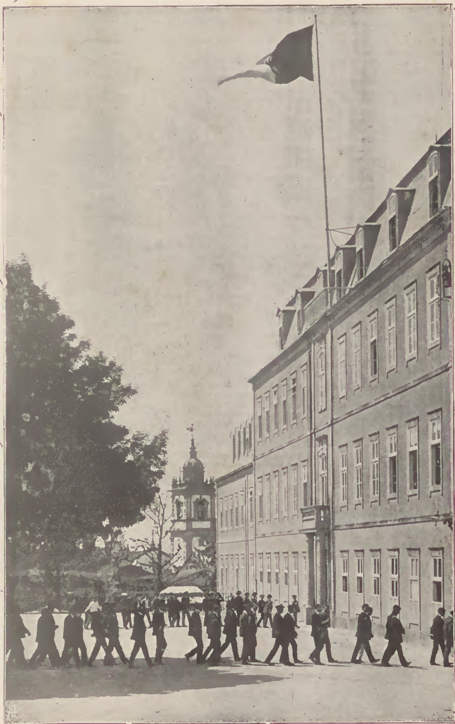
VISTA PARCIAL DO EDIFÍCIO PRINCIPAL DO COLLEGIO Cliché do Collegio.
