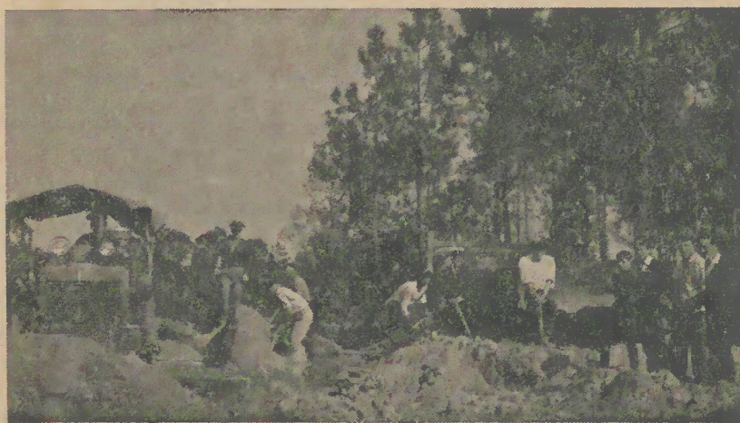
A Quinta do Negreiro está a ser rasgada por máquinas potentes. Preparam-se avenidas e ruas a demarcar o loteamento.
