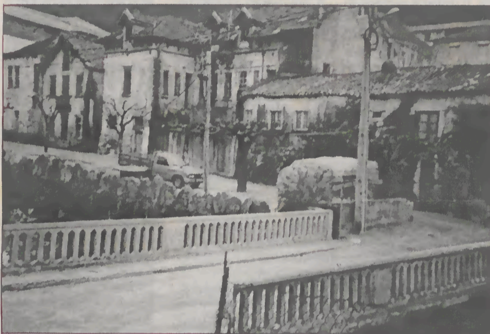
A antiga ponte do Gerês
