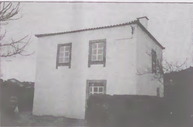
Depois da Intervenção – (S. Bartolomeu do Mar)
