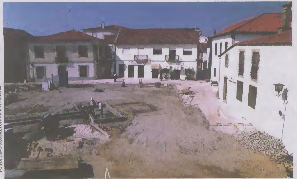
«Panorâmica das obras»
