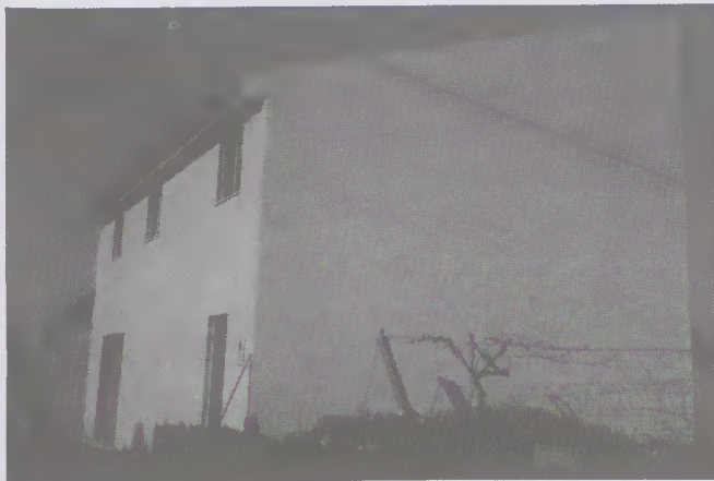
MORADIA DEPOIS DE TERMINADO O RESTAURO
