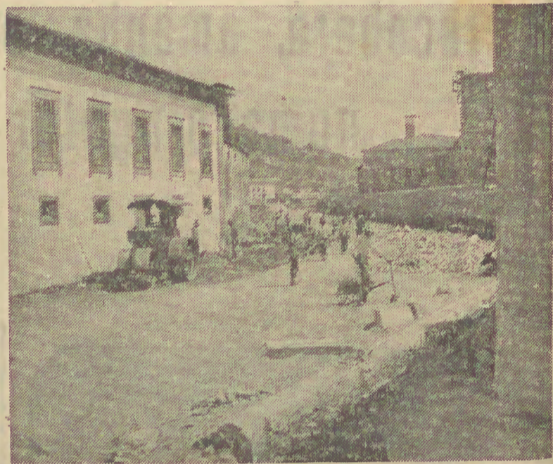
A Rodovia (junto aos Pelames). Obra imponente em que o Estado e a Câmara gastam 16.000 contos
