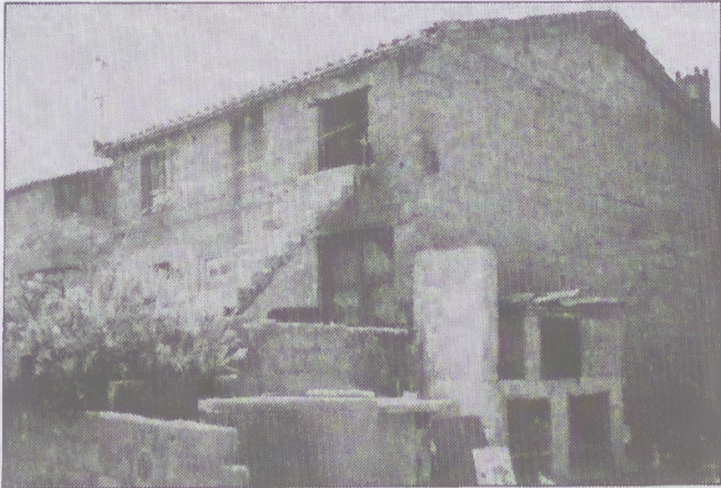
Habitação antes do arranjo
