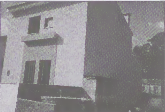
Casa após terminadas as obras
