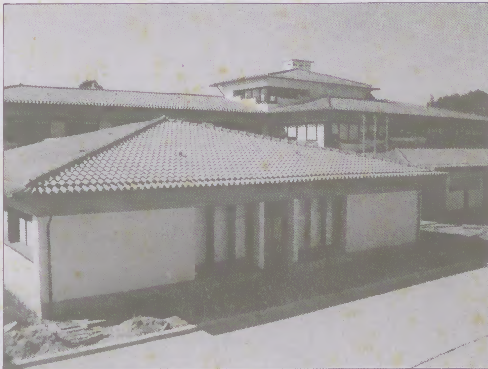
Aspecto parcial, lado Nascente.
