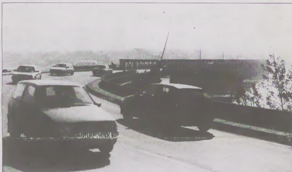
A fatídica curva da Ponte de Fão, antes do encerramento ao trânsito. Hoje está a beneficiar de obras e já tem construído uns resguardos de protecção
