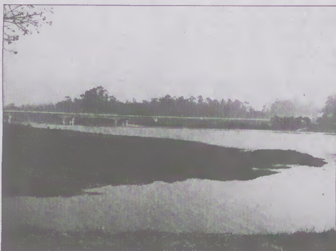
Aspecto panorâmico da Ponte do Caldeirão, onde se vê a sua monumentalidade e extensão. Improvavelmente, por ela passaram já milhares de veículos, por força do encerramento da Ponte de Fão.
