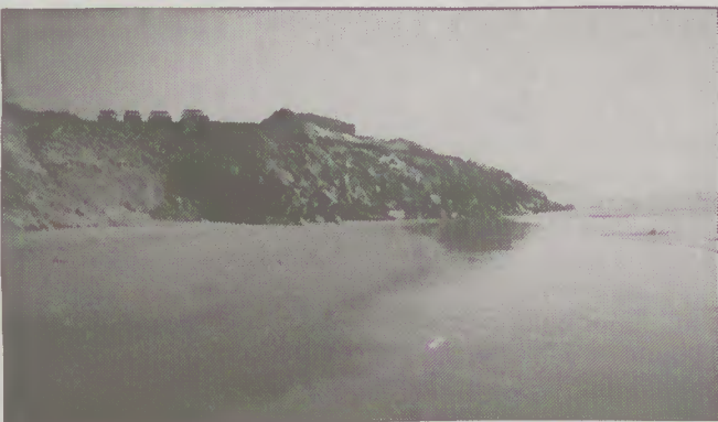
Em Ofir e Apúlia a rápida erosão das praias são bem visíveis
