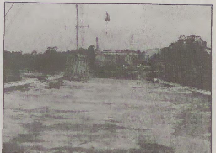
Sobre o tabuleiro da nova Ponte
