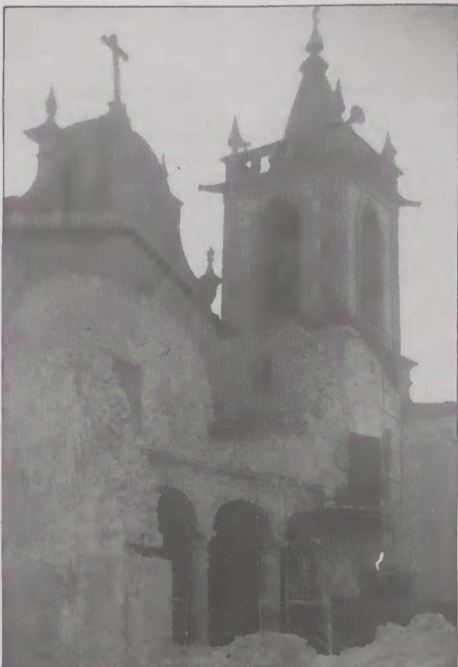
Início das obras.
