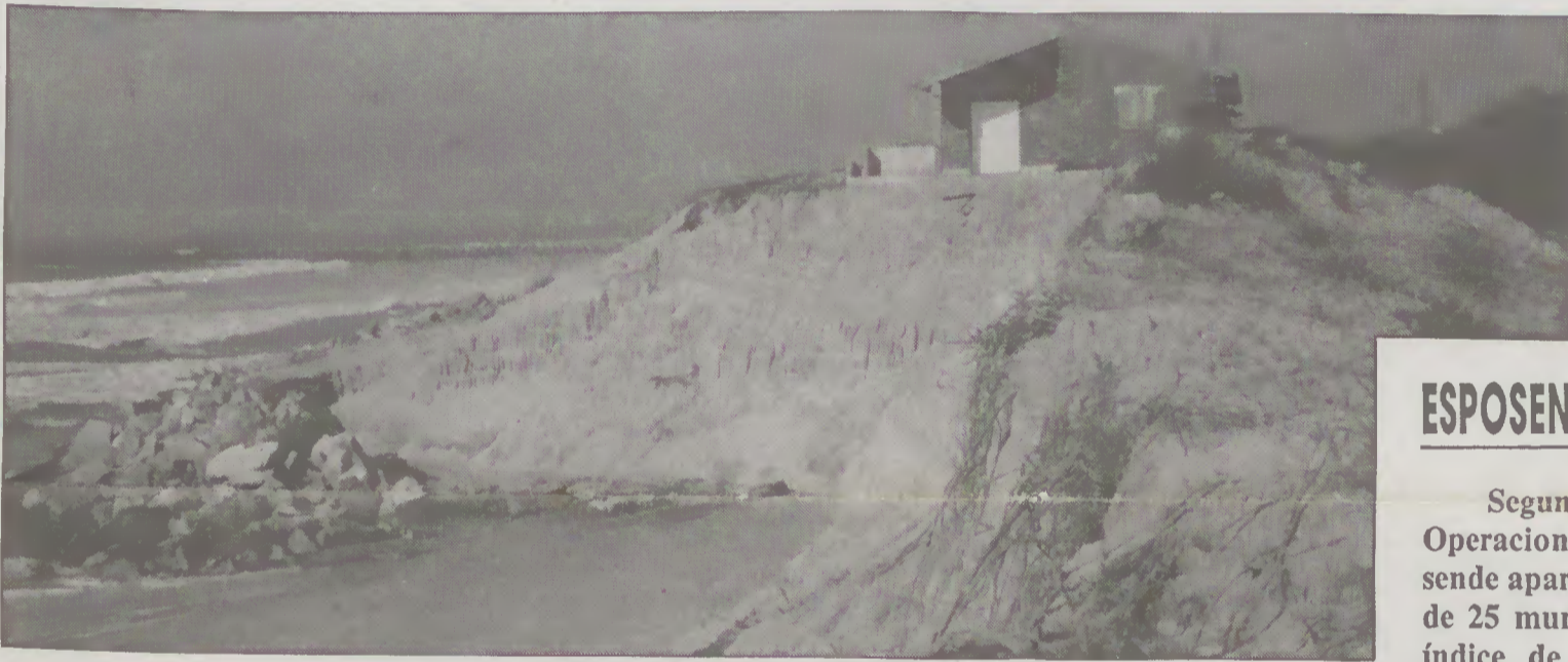
Nas Pedrinhas, casa de praia poderá não resistir ao rigor das próximas marés vivas.
