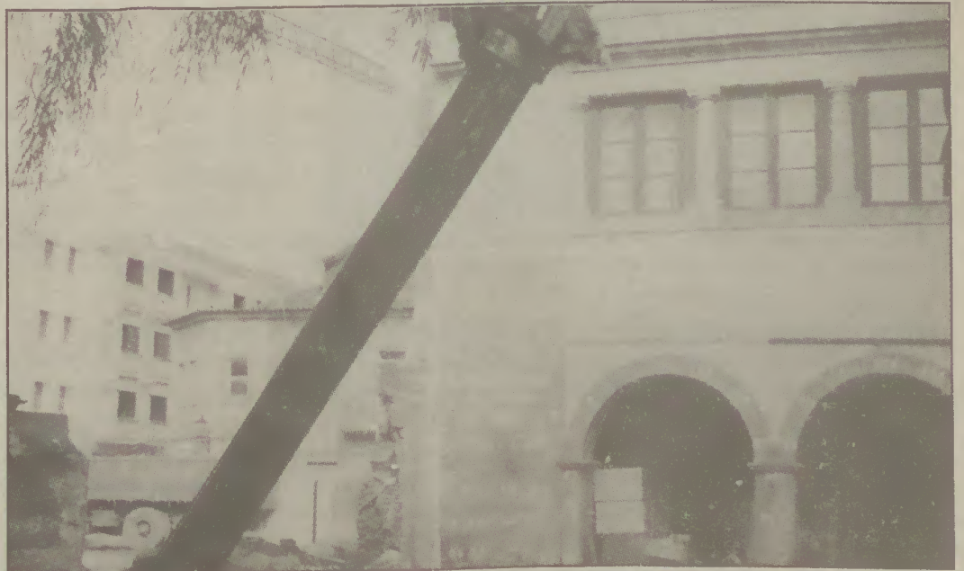
Aspecto das obras de demolição já iniciadas
