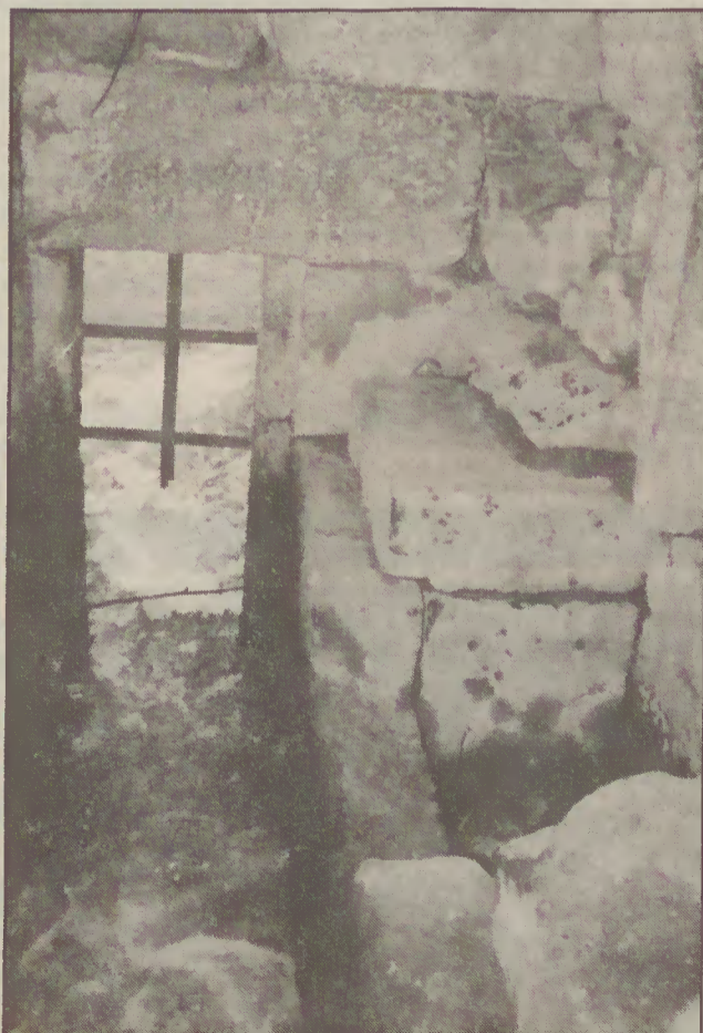
Interior do engenho vendo-se a zona onde se movimentava a roda e o tanque do lado direito
