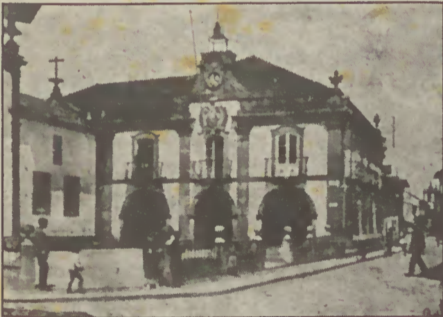
Edifício da Câmara M. de Esposende ainda com o gradeamento primitivo. (Foto de Domingos L. Costa)
