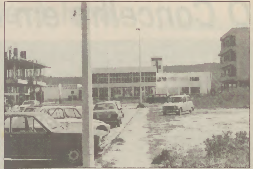
O entaipamento a progredir
