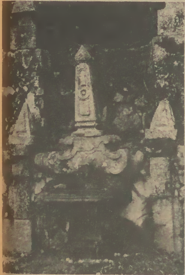
Aspecto duma das fontes da Abadia que também precisam de restauro
