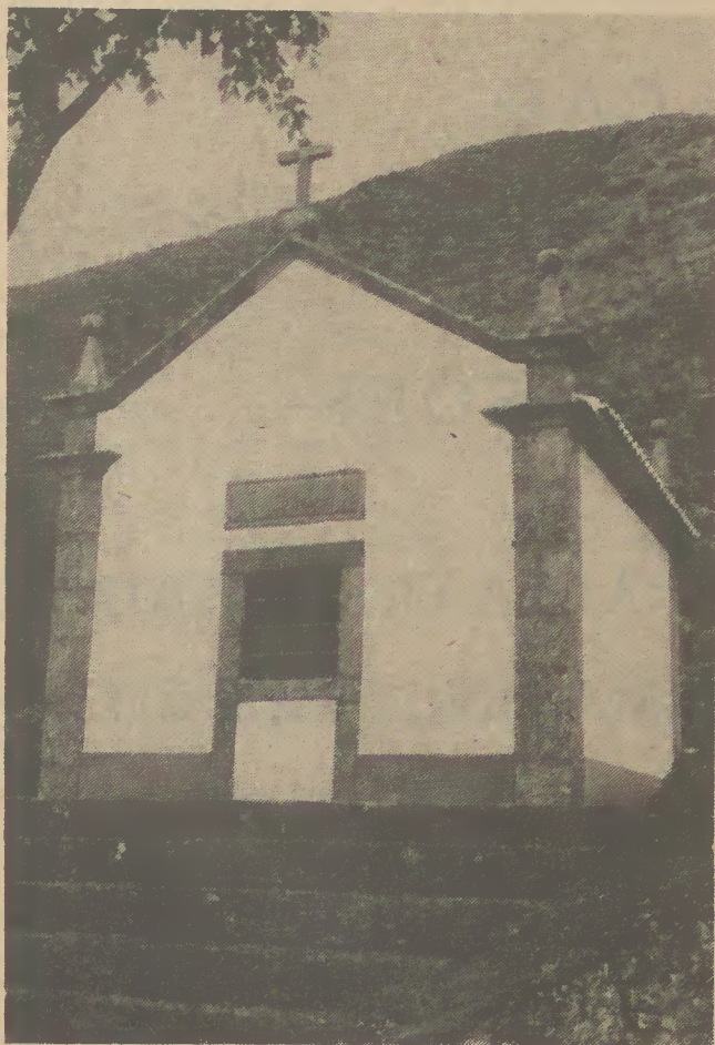
CAPELA DE SANTA MADALENA (acabada de restaurar)
