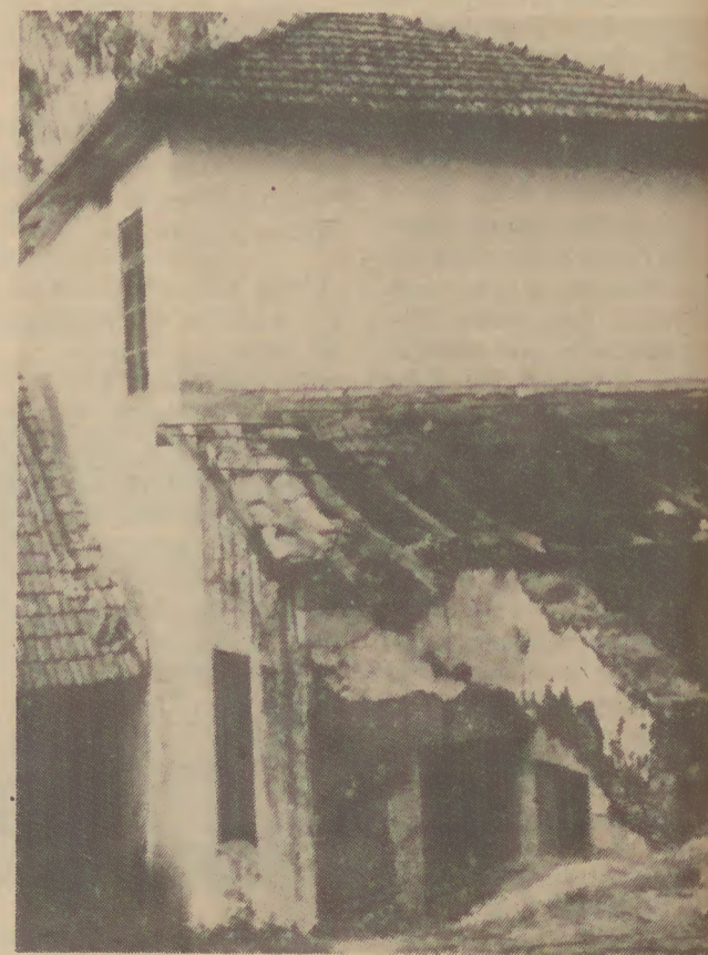
Parte do edifício que se destinava à habitação da professora
