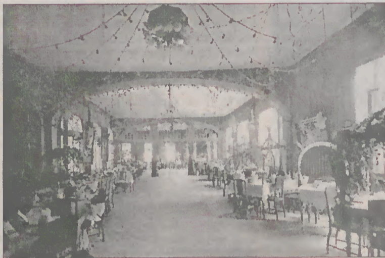
Casino do Hotel Moderno
