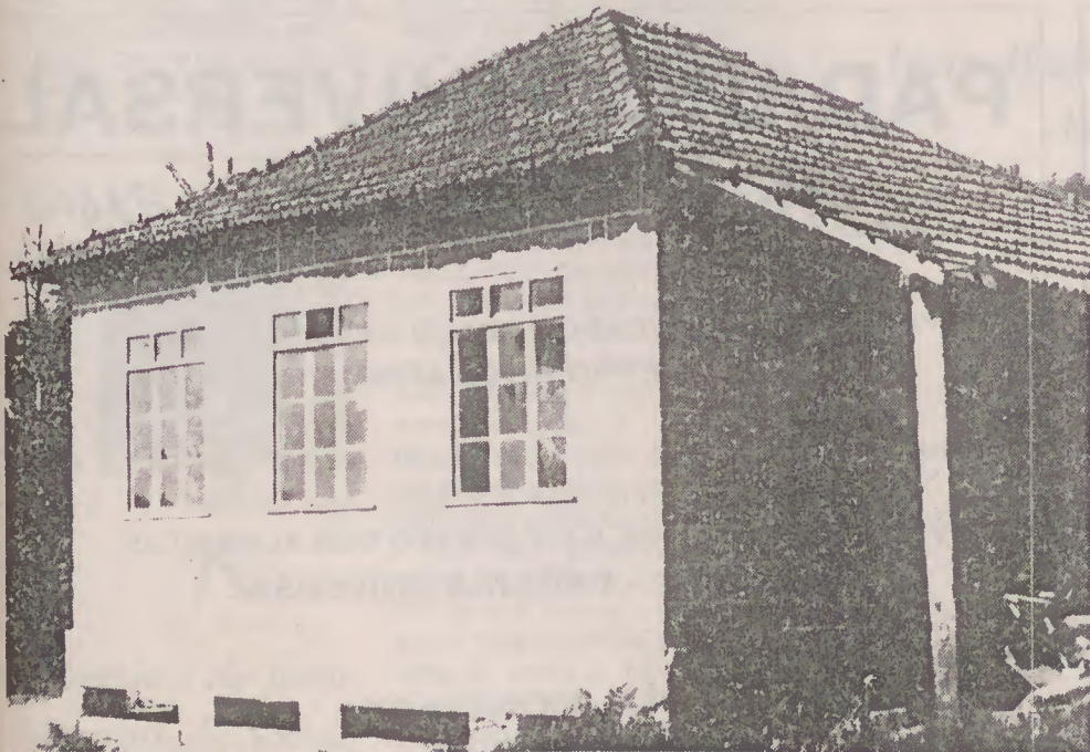
Velho edifício da Junta de Paredes Secas, mesmo ao lado da estrada que desce a Dornelas, onde funciona a Escola Primária
